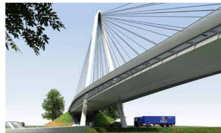
Le 1 er mars, la ministre flamande de la Mobilité et des Travaux publics Hilde Crevits donnait le coup d'envoi de l'achèvement du ring Sud de Gand, aux côtés des bourgmestres de Gand et de la commune voisine de Merelbeke.
