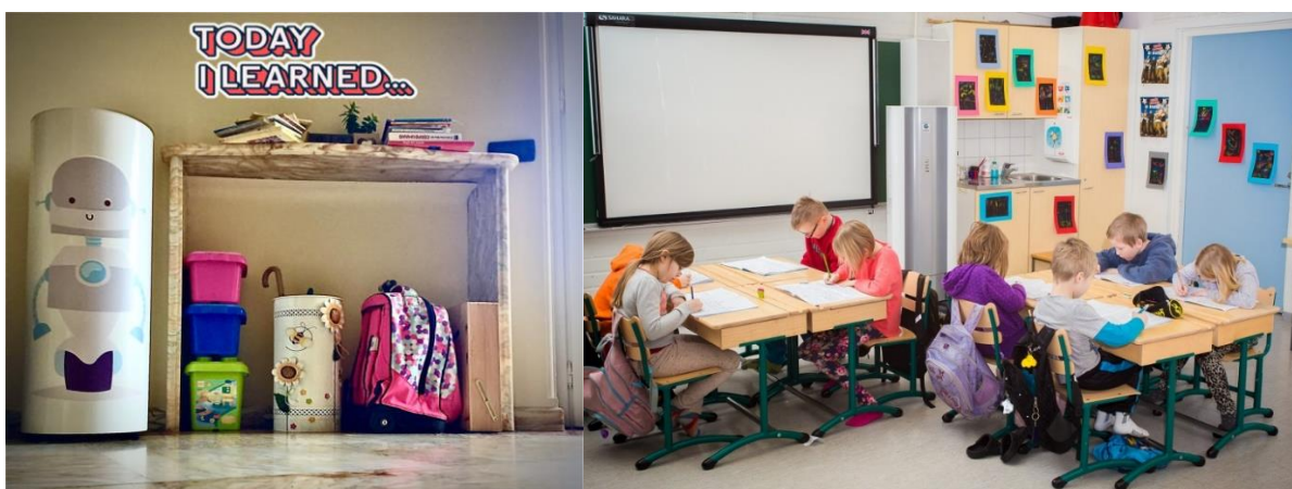
Sur la base du diagnostic établi grâce au monitoring de la qualité de l'air, un plan d'action est proposé, prévoyant par exemple l'installation de purificateurs tels que ceux-ci, déjà installés dans 3000 classes en Finlande (Photos Genano Technology©)
